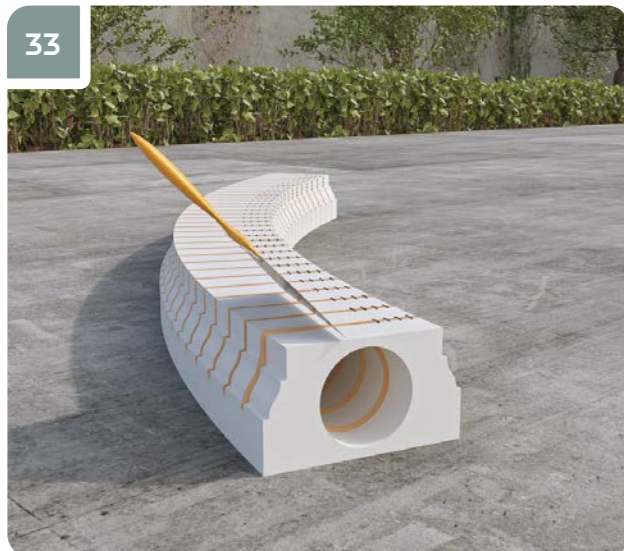
33 Удалить выступившие излишки клея шпателем.
