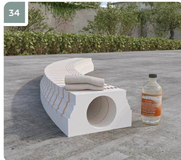
34 Удалить выступившие излишки клея ветошью, смоченной ацетоном.
