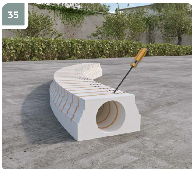
35 Спустя 24 часа удалить скобы.
